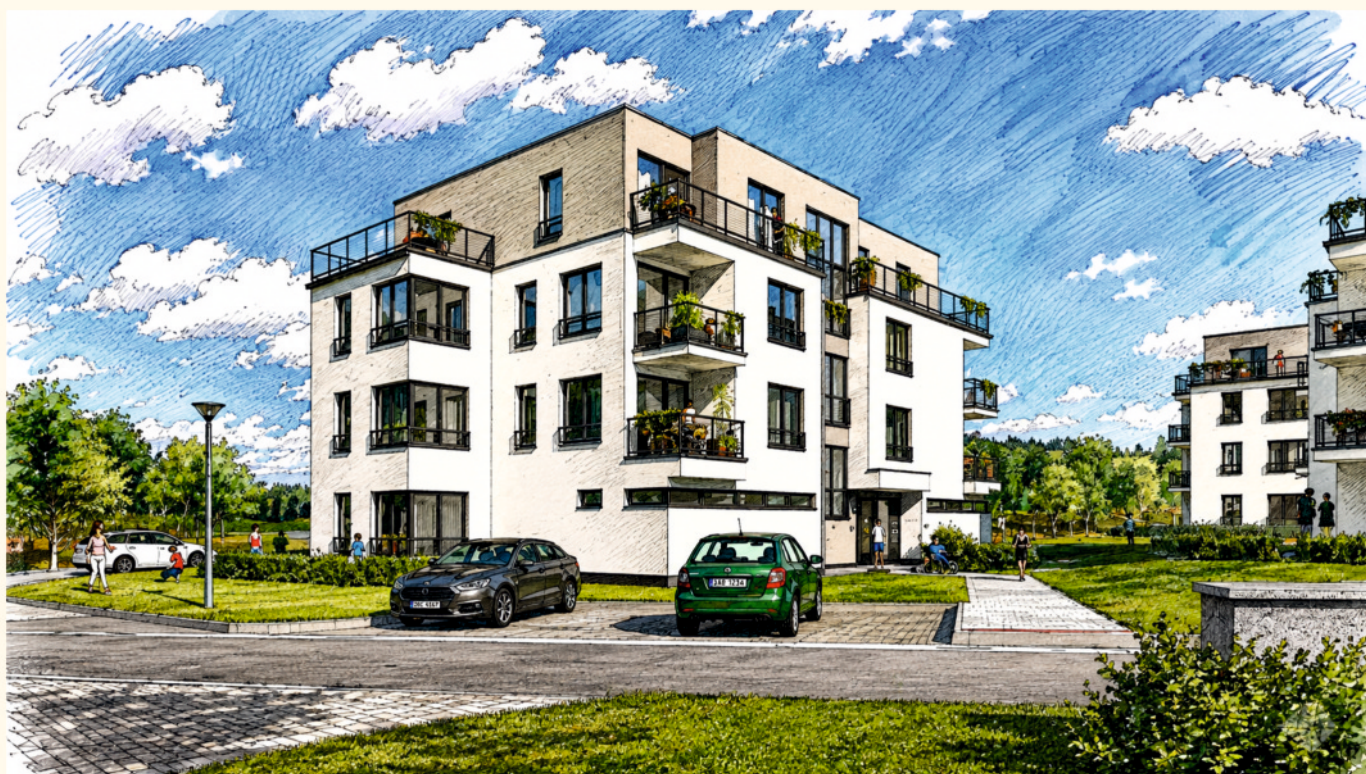
Realizovaná výstavba bytových domů na sídlišti Štěpnice
