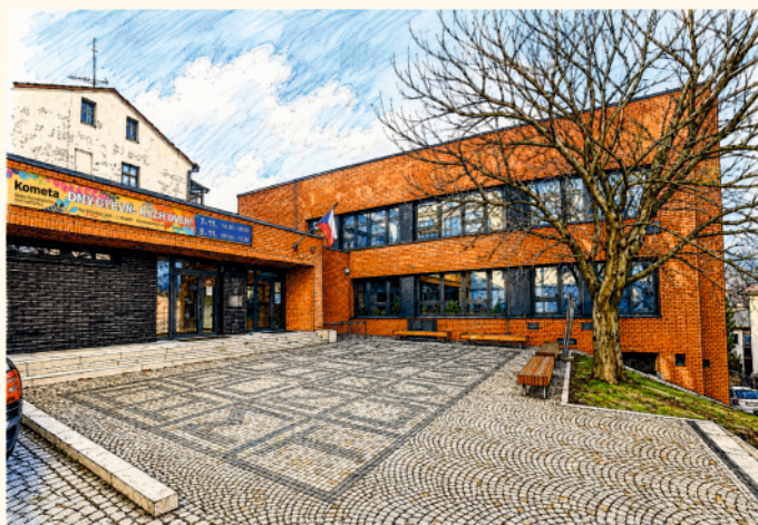
ZŠ Komenského — zateplení, výměna oken, rekonstrukce kotelny
